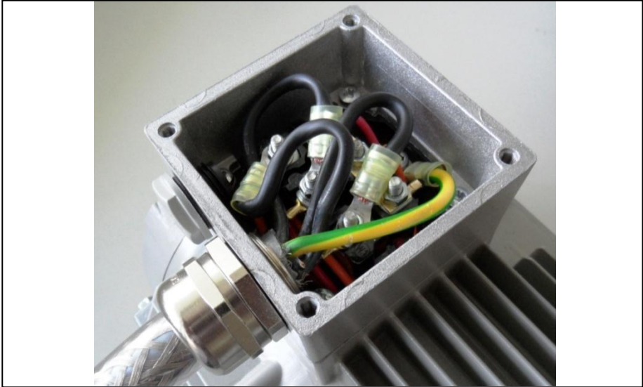
Fig. : 13: Câblage au niveau du boîtier de raccordement du moteur
